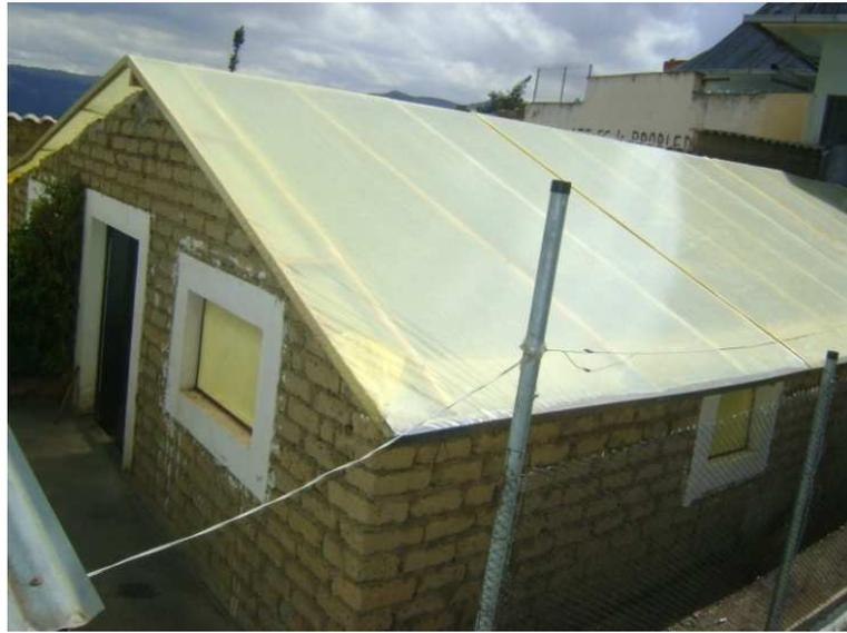
**Figura 11:** Ambiente atemperado (Carpa solar) tipo dos aguas del ensayo
